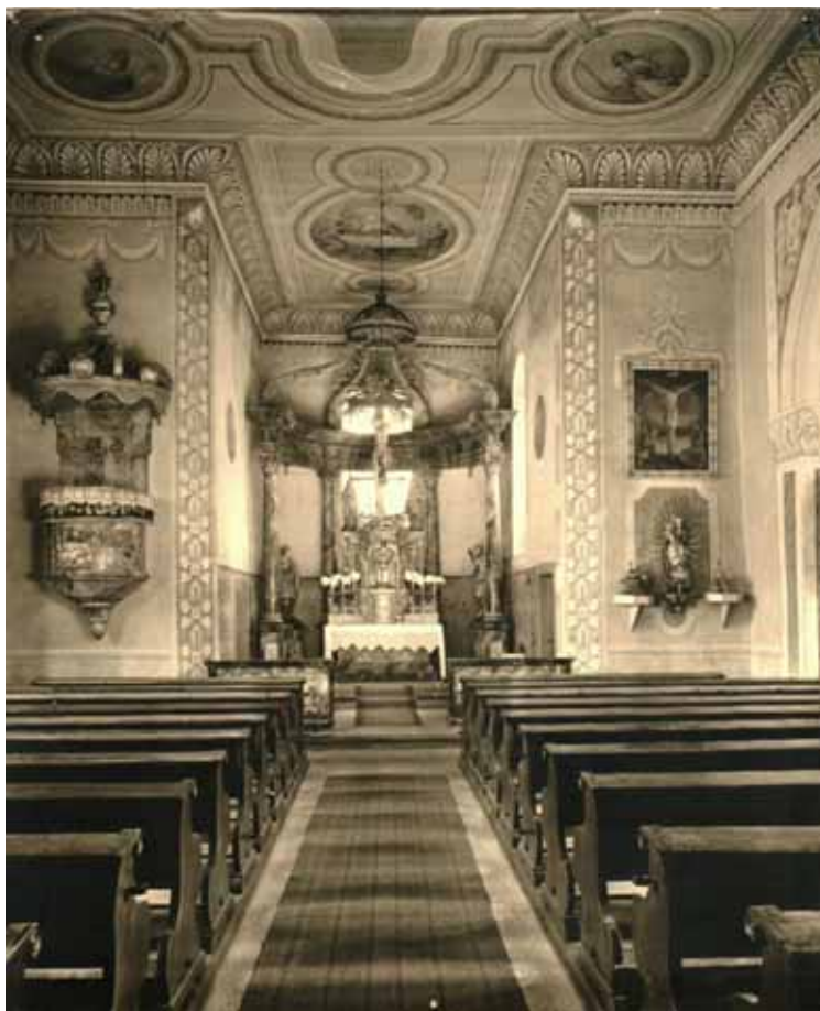
Die Innenansicht nach dem Umbau 1909. Die Ausmalung des Chorraumes erfolgte im Jahr 1915. Die Gestaltung des Langhauses folgte 1920.
